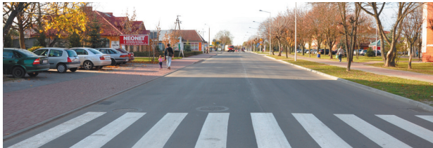
■ Generalny remont dróg w Mieście i Gminie Połaniec
