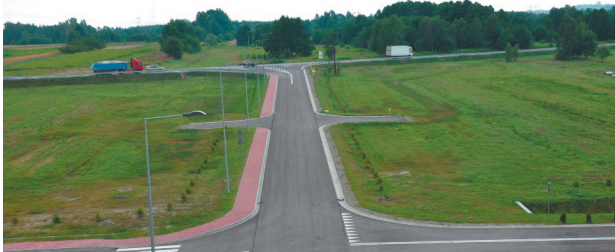
■ Kompleksowo uzbrojone tereny inwestycyjne
