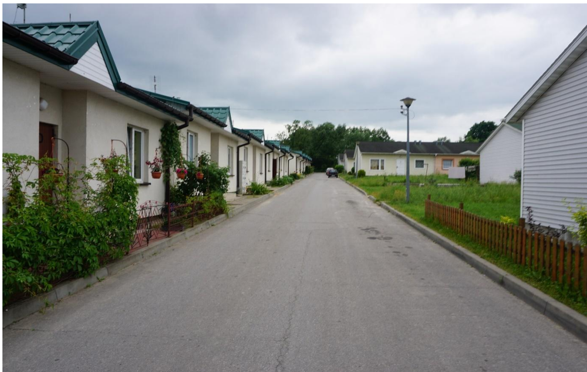
Fotografia 8 Mieszkania socjalne i komunalne zlokalizowane przy ul. Zrębińskiej w Połańcu
